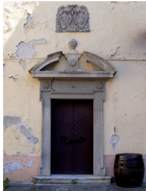
Ranobarokový portál na dvorovej fasáde južného krídla
