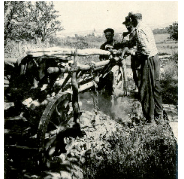
Použitie kameňov z kameníc na vyrovňovanie cesty vo viniciach
